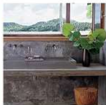
4. Lavamanos de cemento pulido
